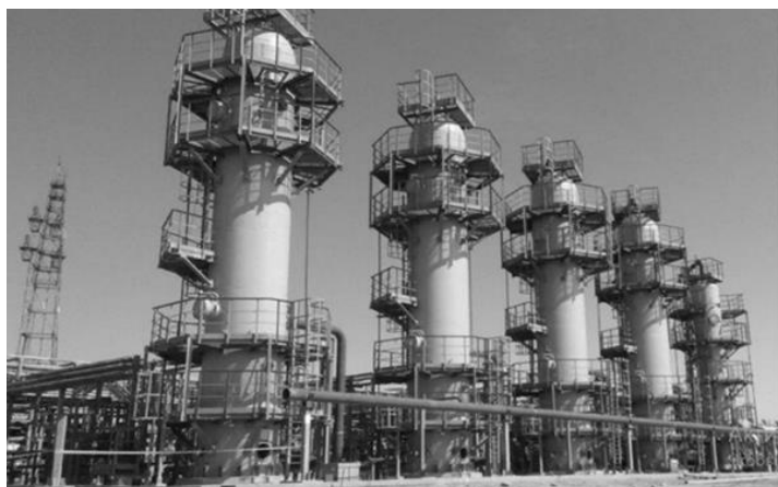
Рисунок 1.11 - Месторождение Бозой. Установка осушки природного газа абсорберами (Казахстан) с применением в верхней части фильтров-сепараторов
