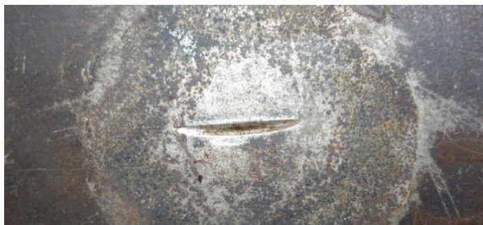
Рисунок 2.26 - Трещиноподобный концентратор напряжений на одном из сегментов трубы
